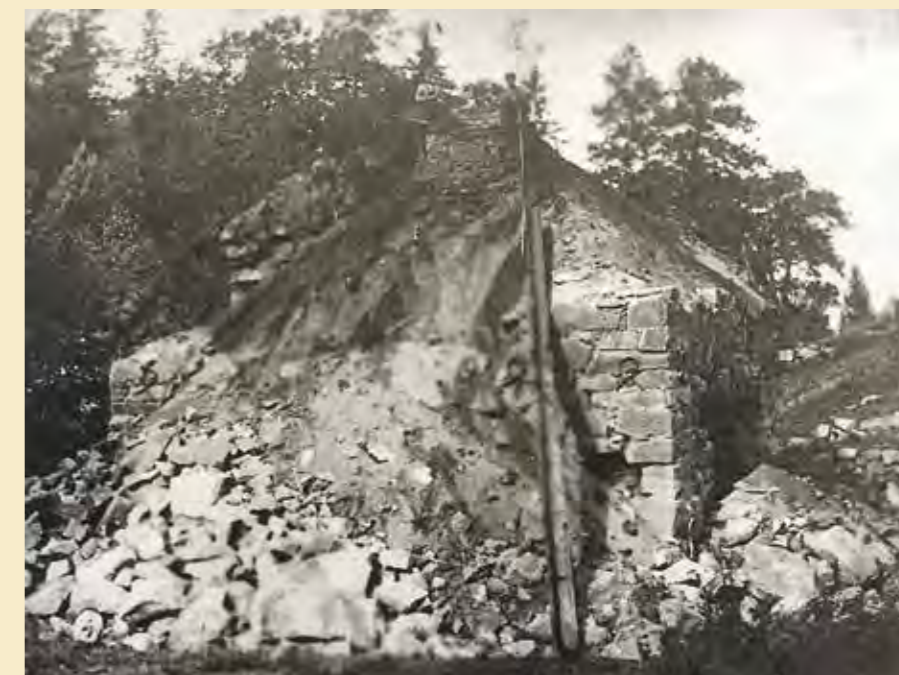
Masugnen i Boarum revs år 1903. Observera de bågiga muren på toppen av den.
