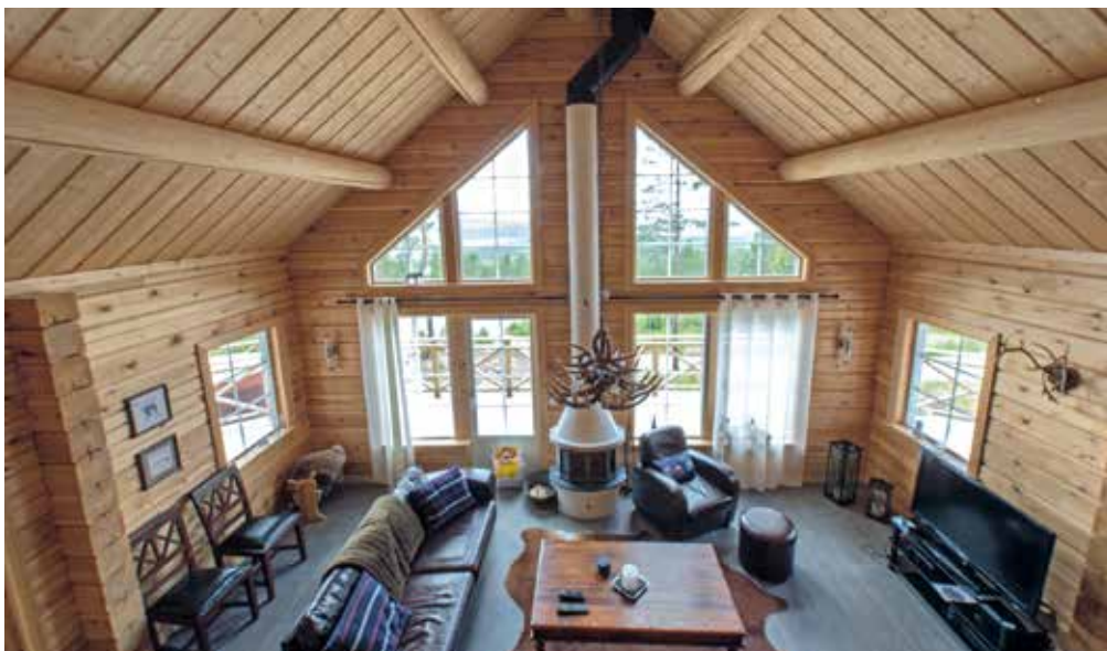
Maskinellt och industriellt tillverkat hus med 20 cm tjocka väggstockar. Foto: Christer Lindgren
