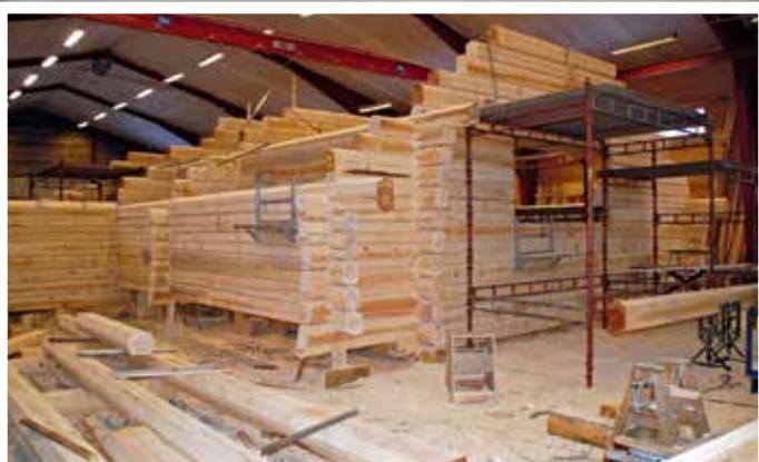
Handtimring av ugnstorkat 20 cm timmer i uppvärmd lokal med travers och arbetsbockar för bra arbetshöjd. Foto Sven-Gunnar Håkansson.
