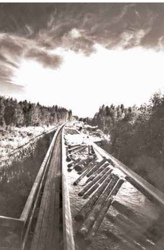
Den tre mil långa timmerrännan som 1898 byggdes från Rämsön, uppströms Älvkarleby, till Bomhus utanför Gävle underhålls fortfarande. Korsnäs bruket tar sitt sötvatten via den och gångbroarna som löper längs rännan har gjort den till en spännande vandringsled. Digitalt museum.
