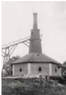
Den här studien omfattade inte de arbetsuppgifter som oftast utfördes av kvinnor vid järnbruken. Bland annat var det kvinnor, och ibland barn och äldre, som ombesörjde "bokningen" av malmen. Det innebar att man med en liten slägga krossade malmen till cirka 5-10 centimeter stora bitar innan den bars upp och hällades ned i masugnen tillsammans med träkol. Bild: Brevens bruks hembygdsförening.
