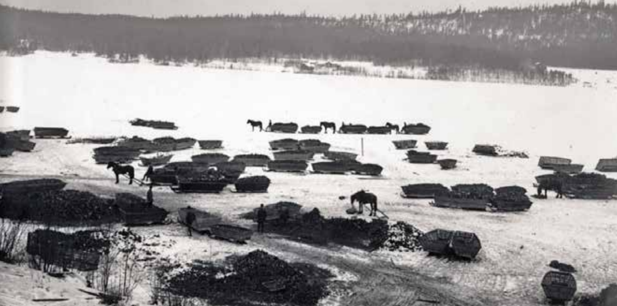
Kolforor vid Ramsjö järnvägsstation 1914 för vidare transport till järnverken. Foto Sveriges järnvägmuseum.
