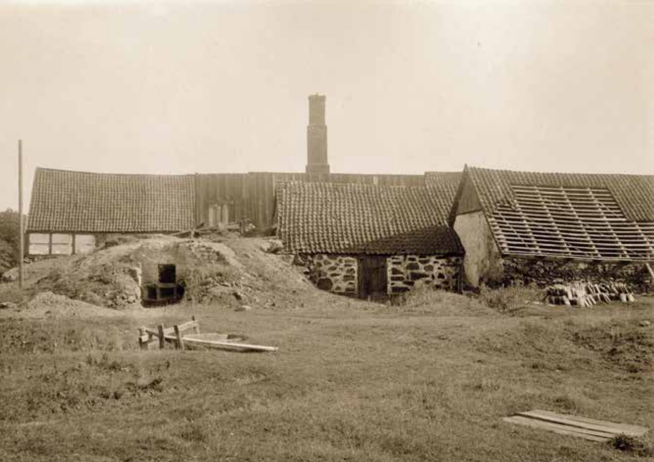
Pannhuset, luthuset och karhuset där slutbehandlingen av alunluten ägde rum och den kristalliserades till alun. Bilden togs i början av 1900-talet. Tekniska museet.
