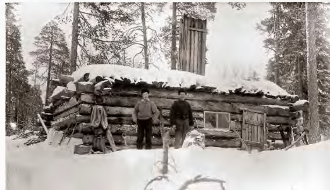
Den här gamla huggarkojan i Lidmyråsens kronopark i Västerbotten var fortfarande i bruk på 1920-talet. Det var sådana här miljöer som Viksten själv hade upplevt under ungdomsåren. Fotot togs den 28 mars 1924. Mediabanken SLU.
