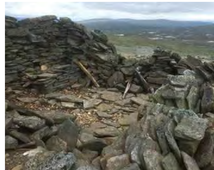
De gamla kallmurade väggarna till smedjan står kvar. Smedjan var helt nödvändig för att vässa borrar i gruvan, och för allt arbete med järn krävs också kol.
