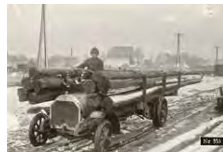
En tidig Scania Vabis Clb , sannolikt 1912 års modell, med massiva gummi hjul och kedjedrift. Tekniska Museet.
