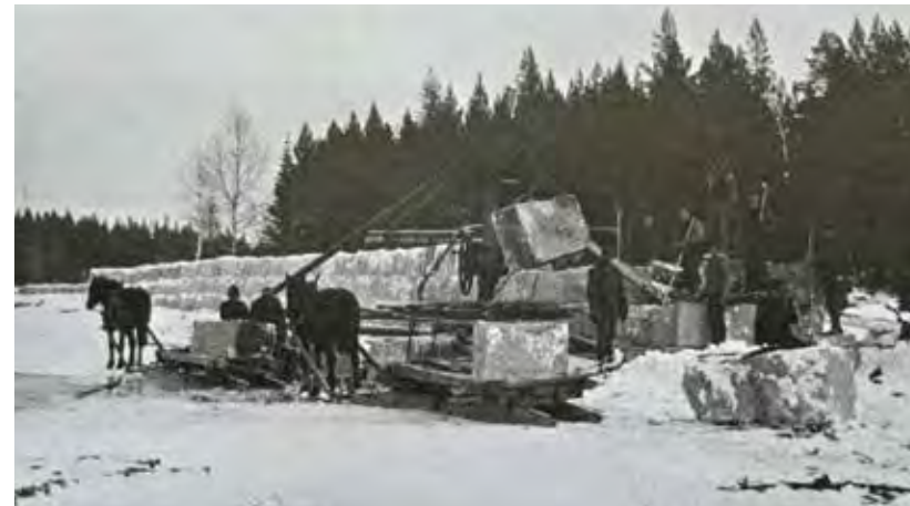
Stenkistorna byggdes vintertid när vattenståndet normalt var lågt och man kunde arbeta på isen. Arbete med Krokökistan i Härjedalen 1925. Bild ur boken De högg i sten .
