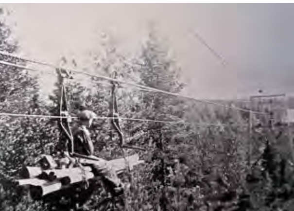
Några hopbuntade plankor hophållna av några vajeröglor räckte att sitta på för smörjaren Anders Gustav Nilsson från Västra Takene, när han regelbundet åkte med för att smörja löphjulen vid stolparna.
