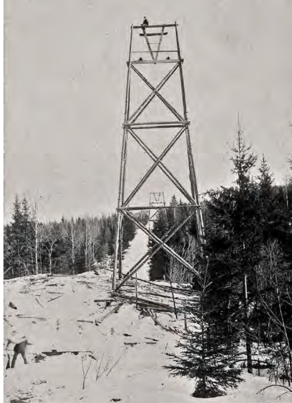
En av bockarna på den 13 kilometer långa timmerlinbanan var hela 30 meter hög. År 1914 var begreppet "säker arbetsmiljö" ännu okänt.
