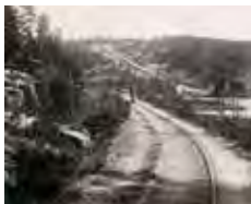
Järnvägen fram mot lutande planet sett från Filipstadshället.
